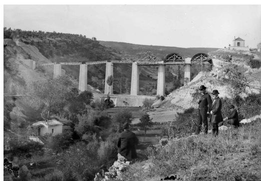
Le viaduc en construction
