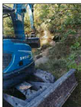
Dépose du bloc béton du regard d'accès à la galerie
